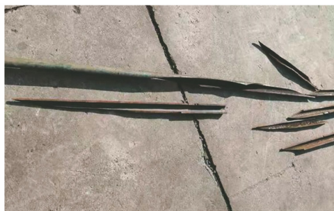
图 1 管道爆裂后的残片形貌
